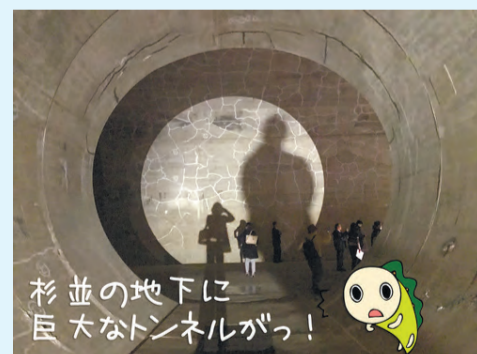
▲神田川・環状七号線地下調節池
