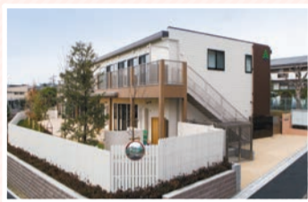
30年4月に新設された認可保育所
