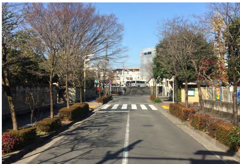
図 3-3 幅員 12mの事例（和田 1 丁目付近）
