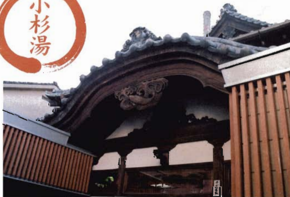
創業昭和8年、入口の重厚な唐破風屋根。欄間の材は今では貴重な屋久杉。夜にはライトアップされます。
