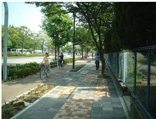
市道大津町線（愛知県名古屋市）
