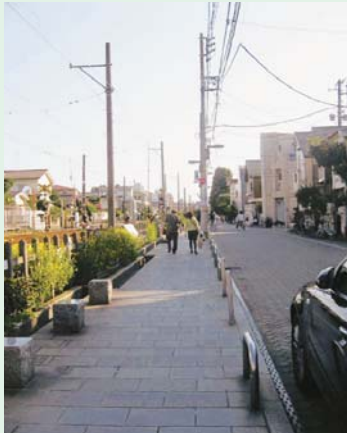
世田谷線沿いの快適な空間
