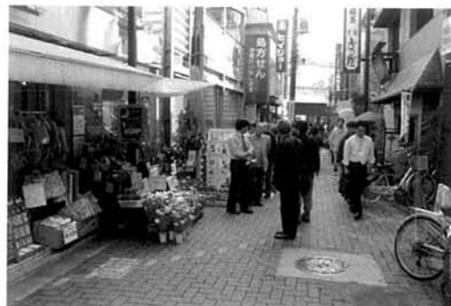
幅員6mに拡幅中の商店街の重点道路
