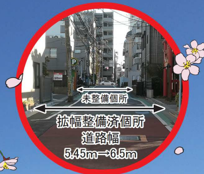
馬橋通り(優先整備路線)の拡幅整備
