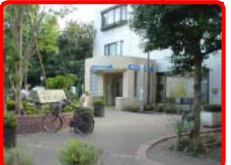
東高円寺駅EV前
