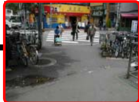
路面に凹凸がある
