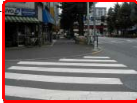
誘導ブロックが未整備
