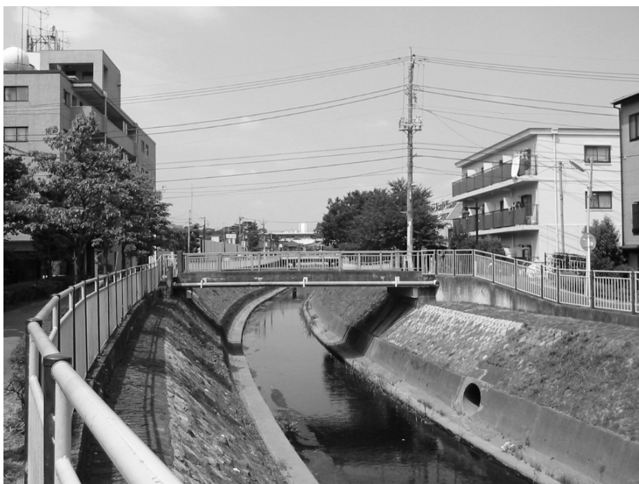
善福寺川堀ノ内橋の様子
