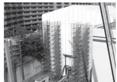
すでに、管理棟や煙突周囲の建物の解体が完了しました。解体時は、周辺環境への影響(騒音・粉じん)を抑えるため、解体用テントで覆っていました。現在行われている、プラットホームの解体にも、解体用テントが使用されています。
