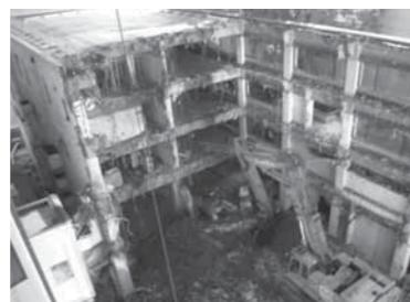
テントの中での解体作業の様子です。解体で発生したコンクリート片や鉄筋は、分別して適正に再利用されます。
