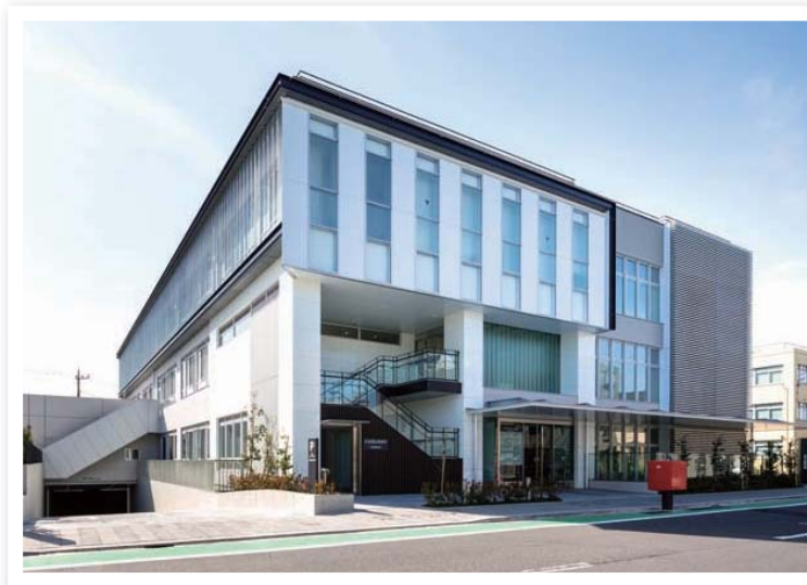
誰もが気軽に利用できる福祉と暮らしのサポート拠点 「ウェルファーム杉並」
