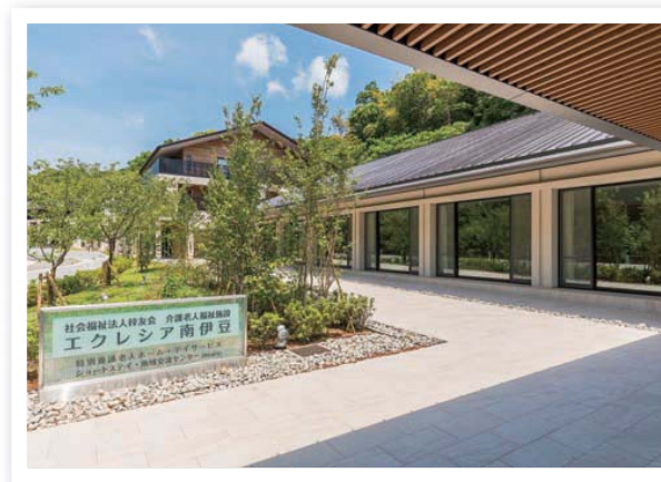
静岡県南伊豆町との連携により整備した 特別養護老人ホーム「エクレシア南伊豆」
