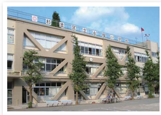
区立施設(小学校)の耐震化の例
