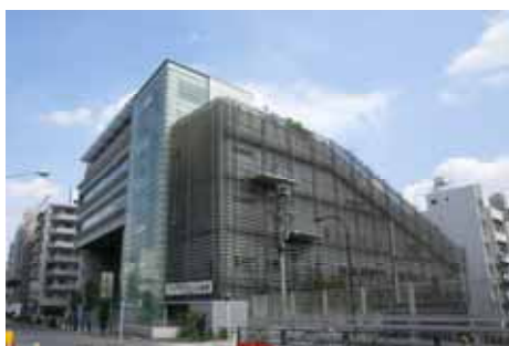
コンクリートとガラスを組合せた外壁
