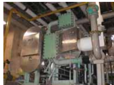
(地下 3 階の冷温水発生機)
