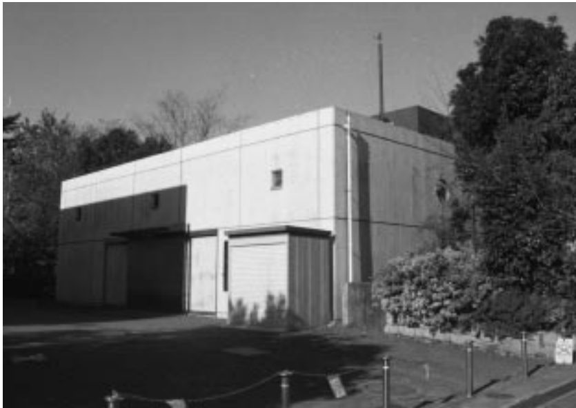
和田第二災害備蓄倉庫
