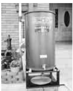
▲小型雨水貯留槽(一例)
