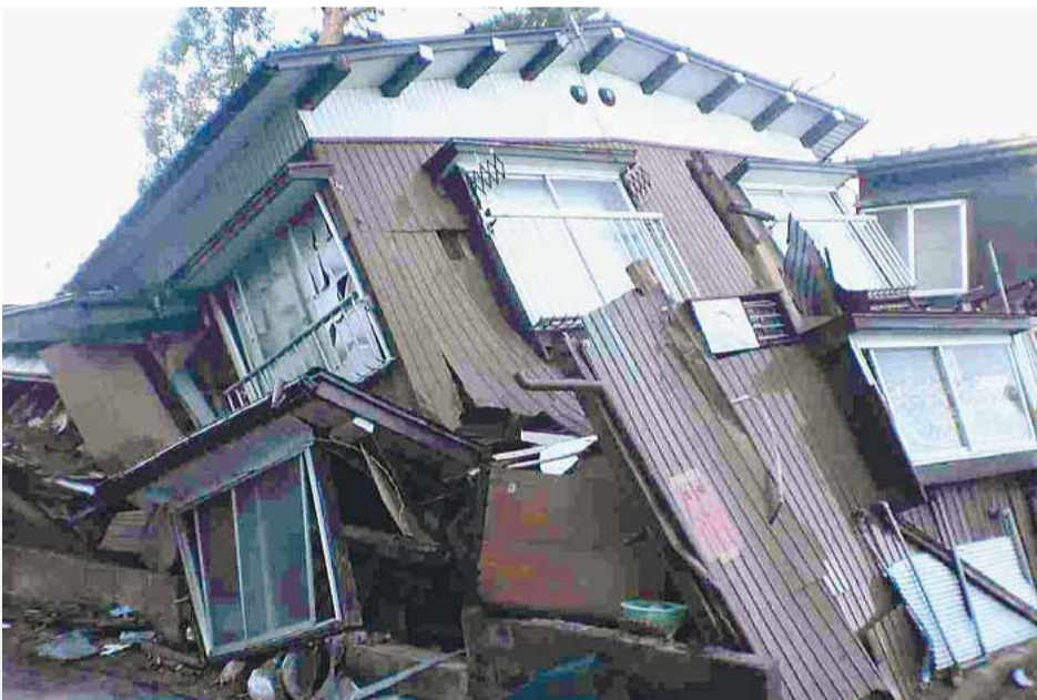
▲新潟県中越沖地震で倒壊した家屋 (平成19年7月、小千谷市内)
