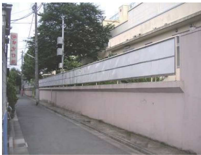
アクリル板の目隠しフェンス
