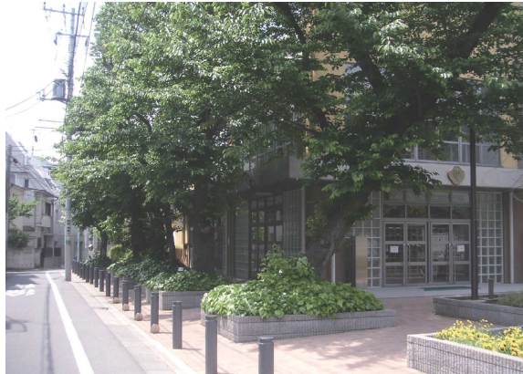
既存のサクラを活かした建物配置 (泉南中学校)
