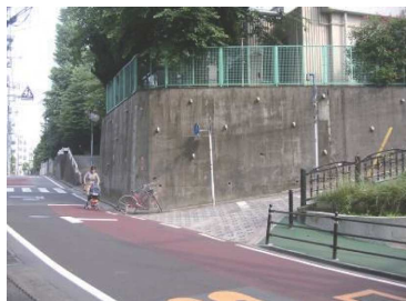
高く垂直のコンクリート擁壁
