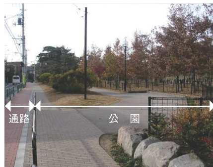
歩道部の舗装材を入口内部にも敷設 (柏の宮公園)
