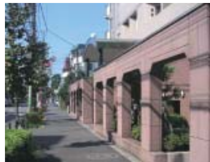
セットバックして建つ建物の植栽スペースの前に連続するゲートを設置
