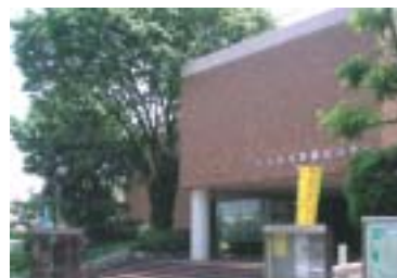
安心感のあるレンガタイル貼の外壁
