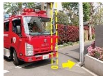
狭あい道路の電柱移設後
