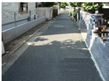
狭あい道路の拡幅前
