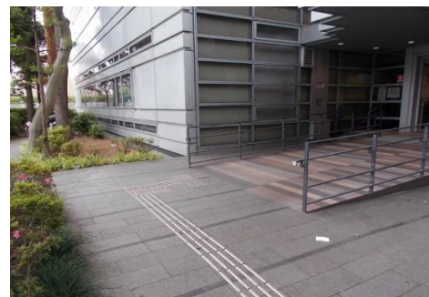
スロープ設置例 (中央図書館)
