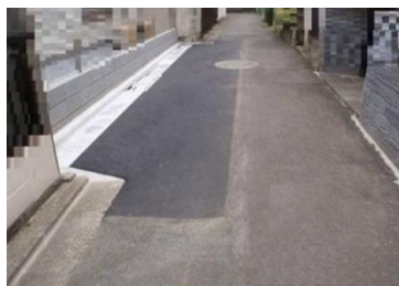
狭あい道路の拡幅後
